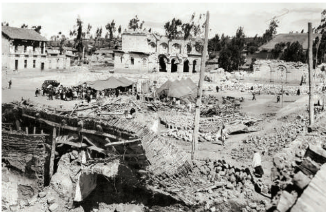
Terremoto de Ambato, 1949
