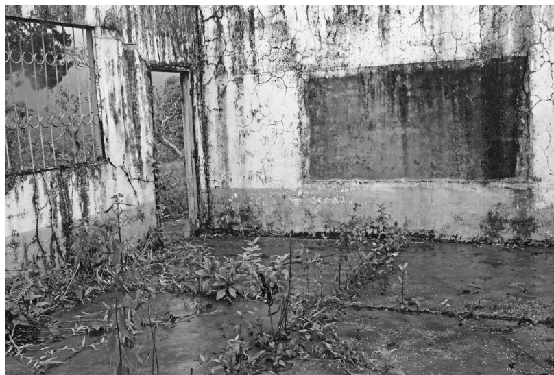
Interior de escuela en zona rural de San Carlos.
