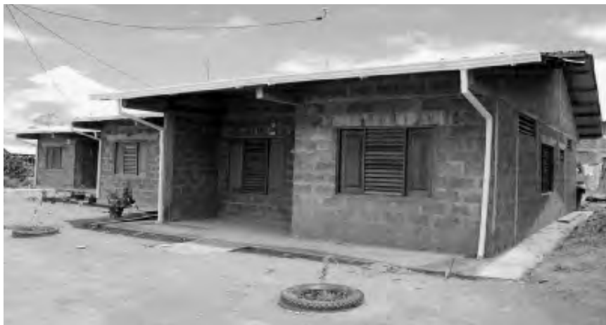
Foto 11. Estructura de las viviendas en el nuevo Bellavista.
